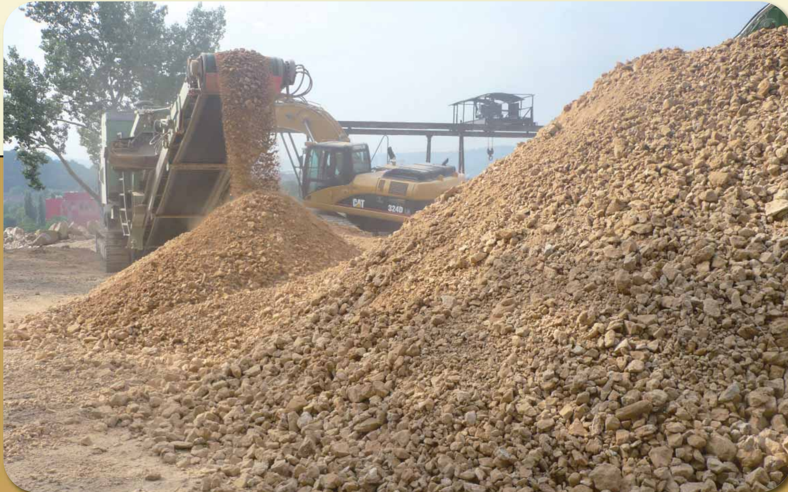
Travertinschotter für den Stadtpark wird vor Ort gebrochen.
