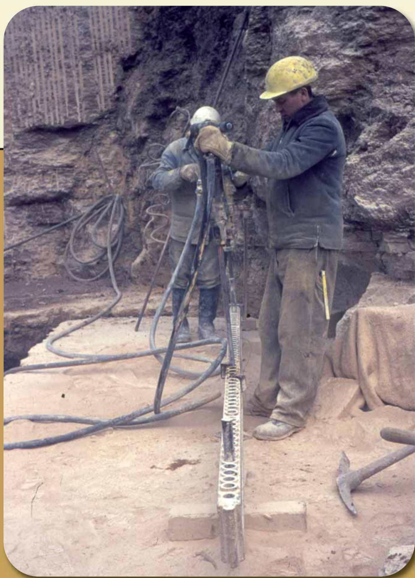
Große Steinblöcke wurden mit Hilfe einer Bohrlehre durchbohrt und anschließend mit Keilen gespalten. Foto: © Hans Peter Kuban
