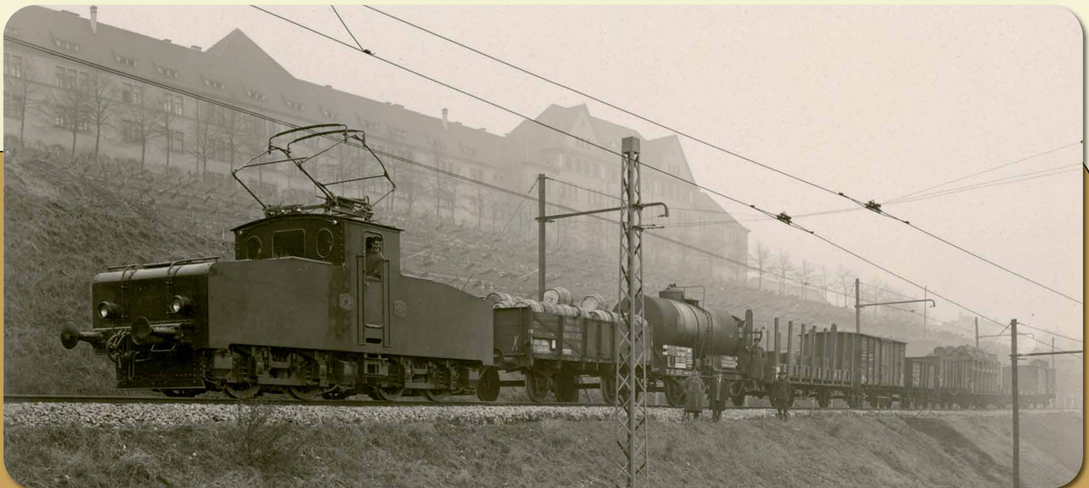
Die 1925 gebaute, vierachsige Elektro-Lokomotive der Berliner Maschinenbau AG mit der Nummer 8662 wurde an die Stadt Stuttgart ausgeliefert.
